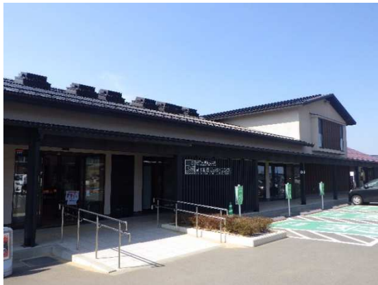
段差をなくしたスロープ
